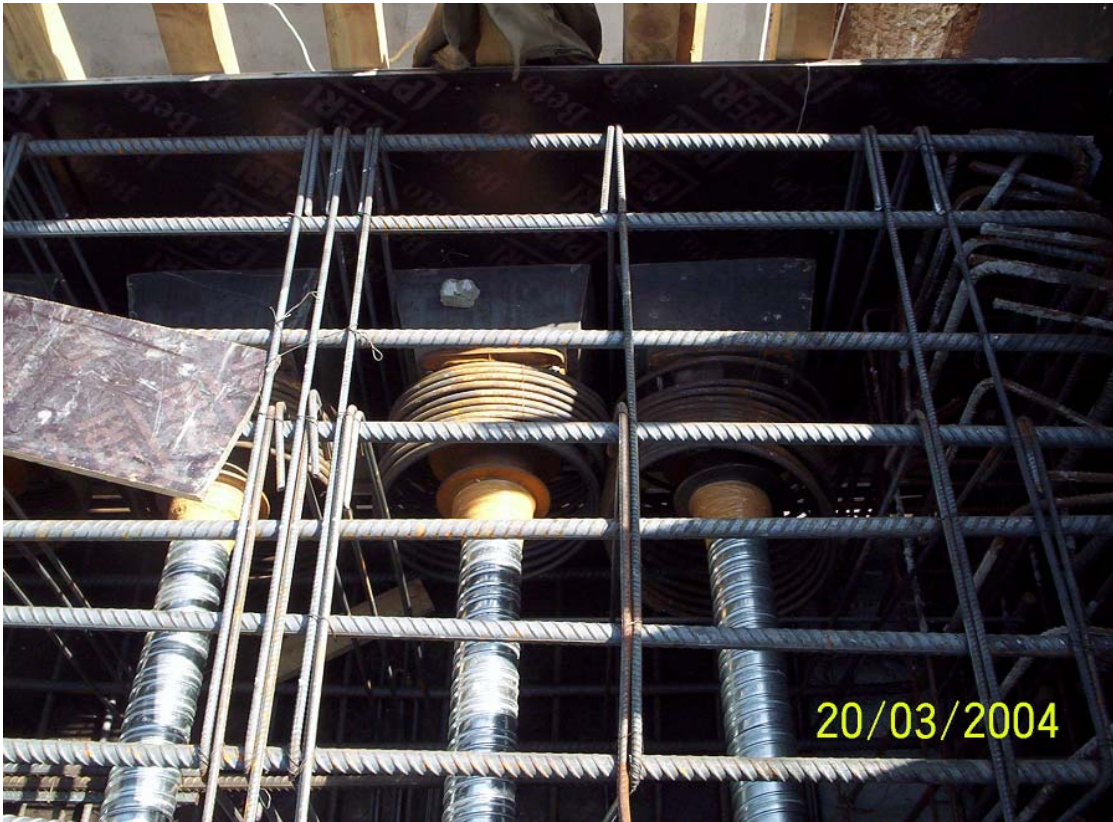
Şekil 8 : Patlatma Donatısı, Spiral Donatı
