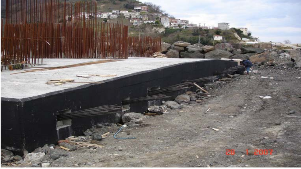
Şekil 14: Radye Temelde Ard Germe Uygulaması
