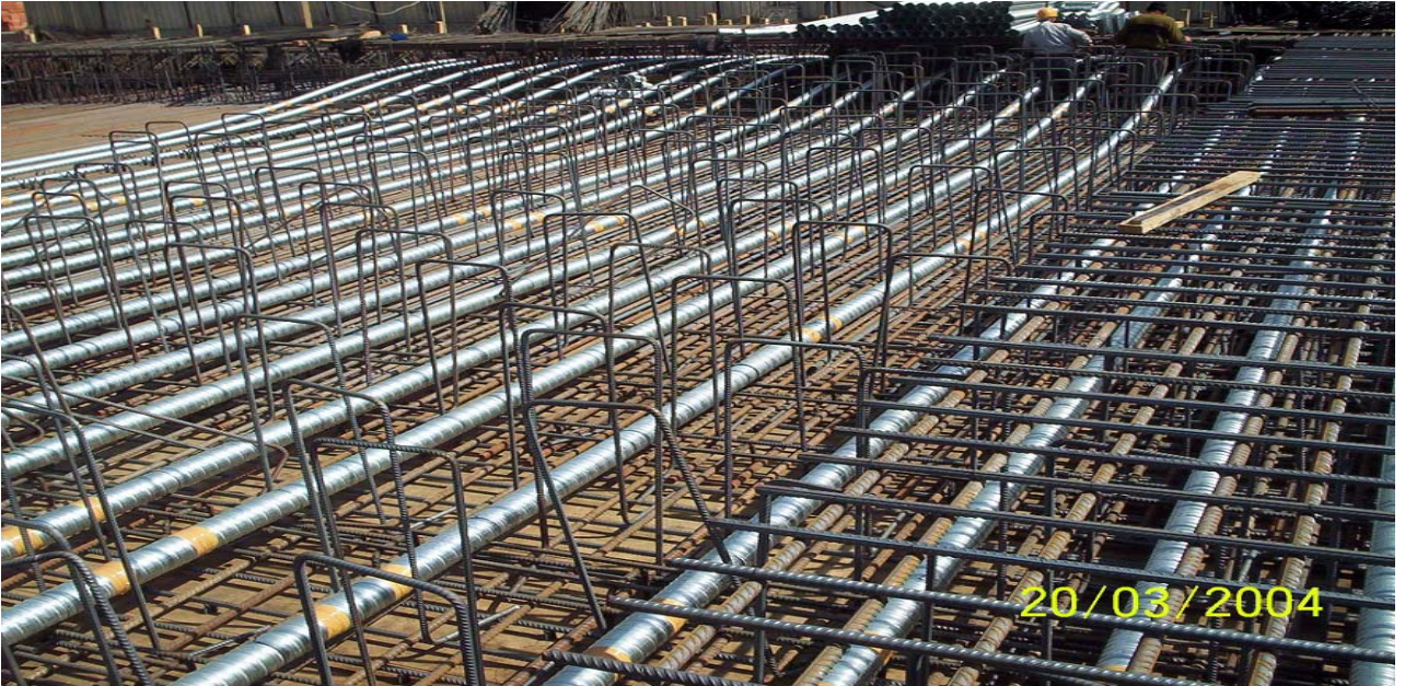
Şekil 10: Sheraton Ankara Otelinde, Kılıfların Yerleştirilmesi
