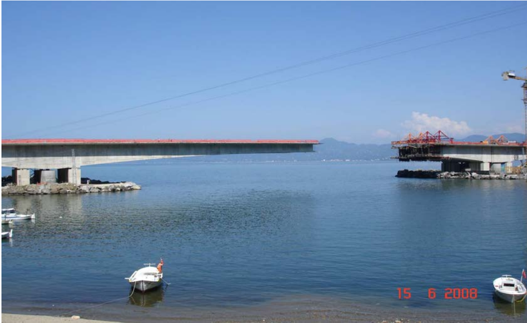
Şekil 15 : Ardgerme ile bir Köprü Uygulaması
