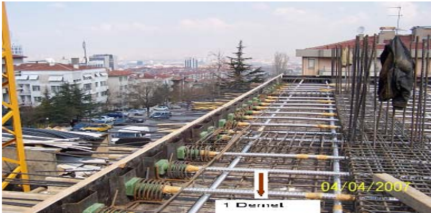
Şekil 6 : Ard Germe Halat Kılıfları.
