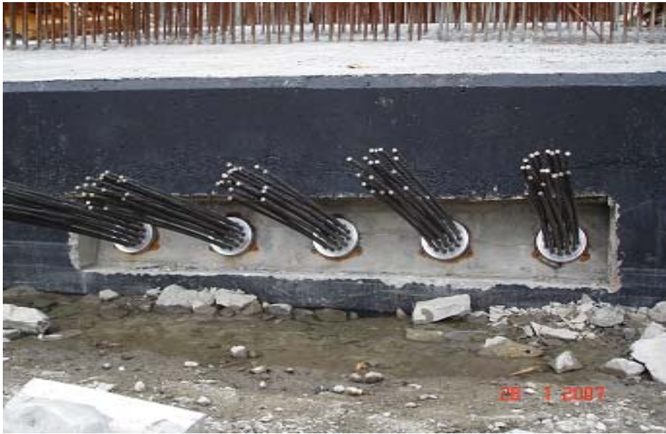
Şekil 7: Demetler halindeki Halatlar Gerdirilmeden Hemen önce
