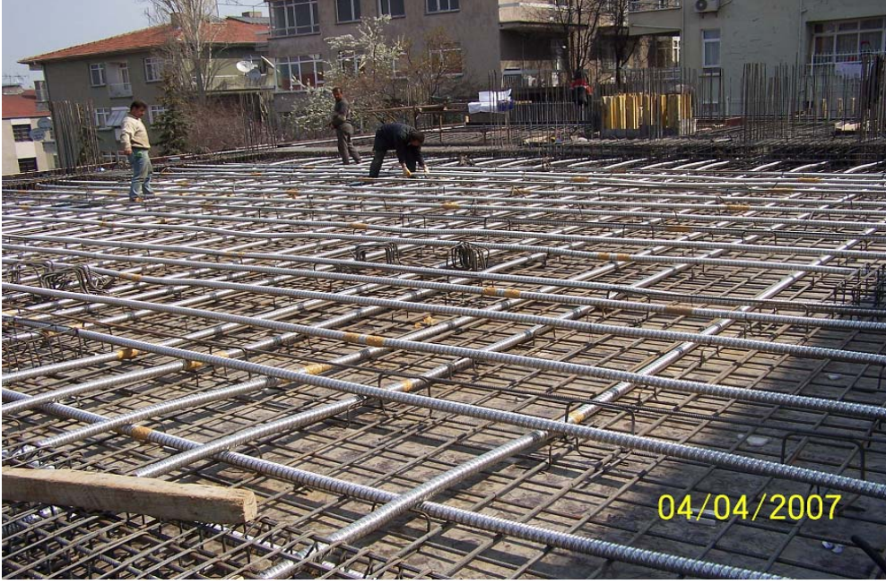
Şekil 13 : NTV Binası İki Yönlü Ardgerme Döşemesi Uygulaması
